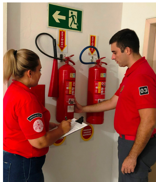
Análise de projetos de prevenção a incêndio e pânico no CAT dos Bombeiros Voluntários de Joinville (no alto) e equipe do CAT dos Bombeiros Voluntários de Jaraguá do Sul durante vistoria
