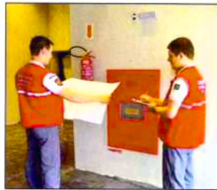
Verificação do sistema preventivo em edificação
