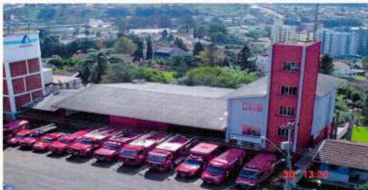
Foto: Sede da Regional no Município de Caçador
