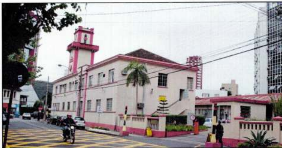
Foto: Sede da Regional no Município de Joinville
